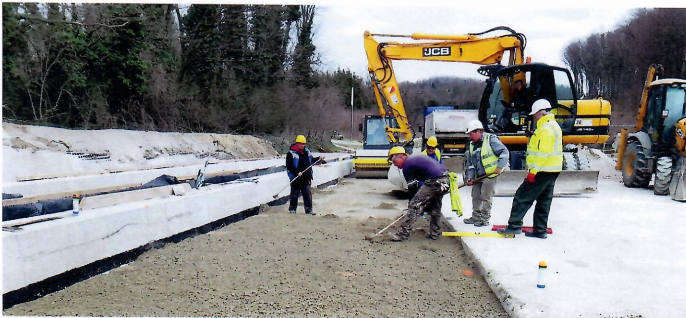
Az M76-os út építése leköti a cég kapacitásának körülbelül a felét
